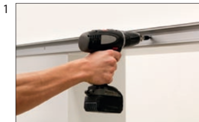
Anbringen der Laufschiene von vorn
