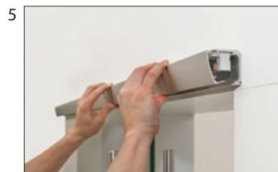
Einclippen der Clipsblende
