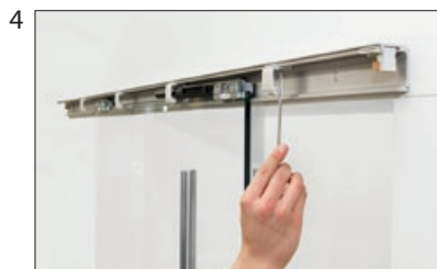
Montage der Clipsblendenhalterung mit demselben Innensechskantschlüssel
