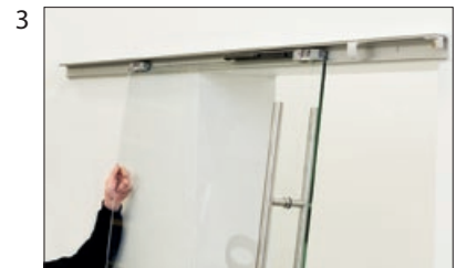
Einhängen des Türflügels in die Laufschiene von vorn
